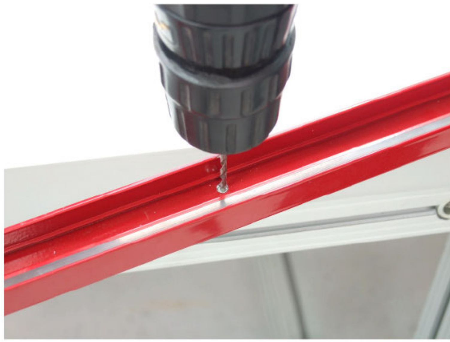
9 forare la guida a lato del magnete in tre punti
