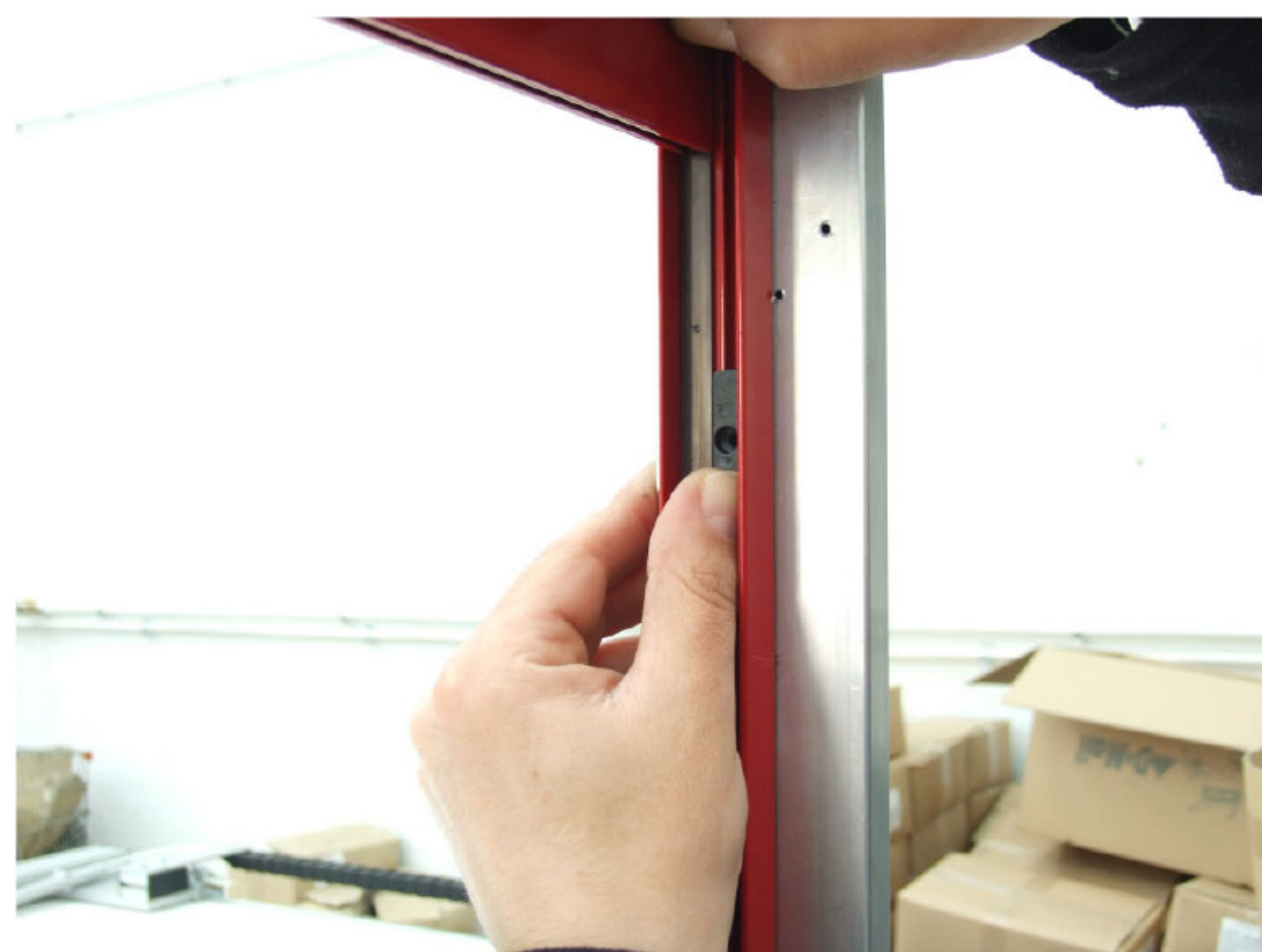
16 fissa la guida con tacchettino senza forare
