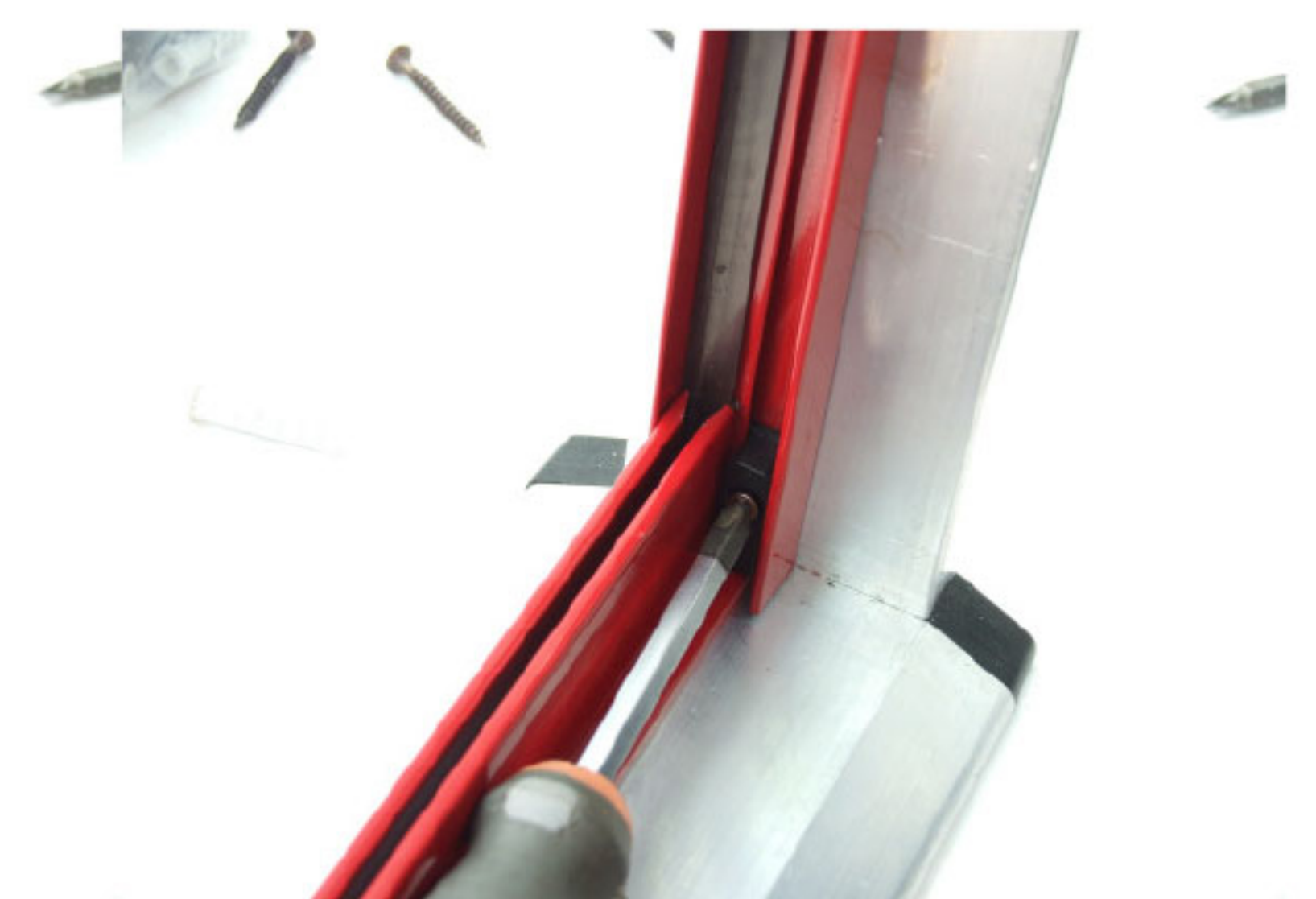
14 fissa la guida con tacchettino senza forare
