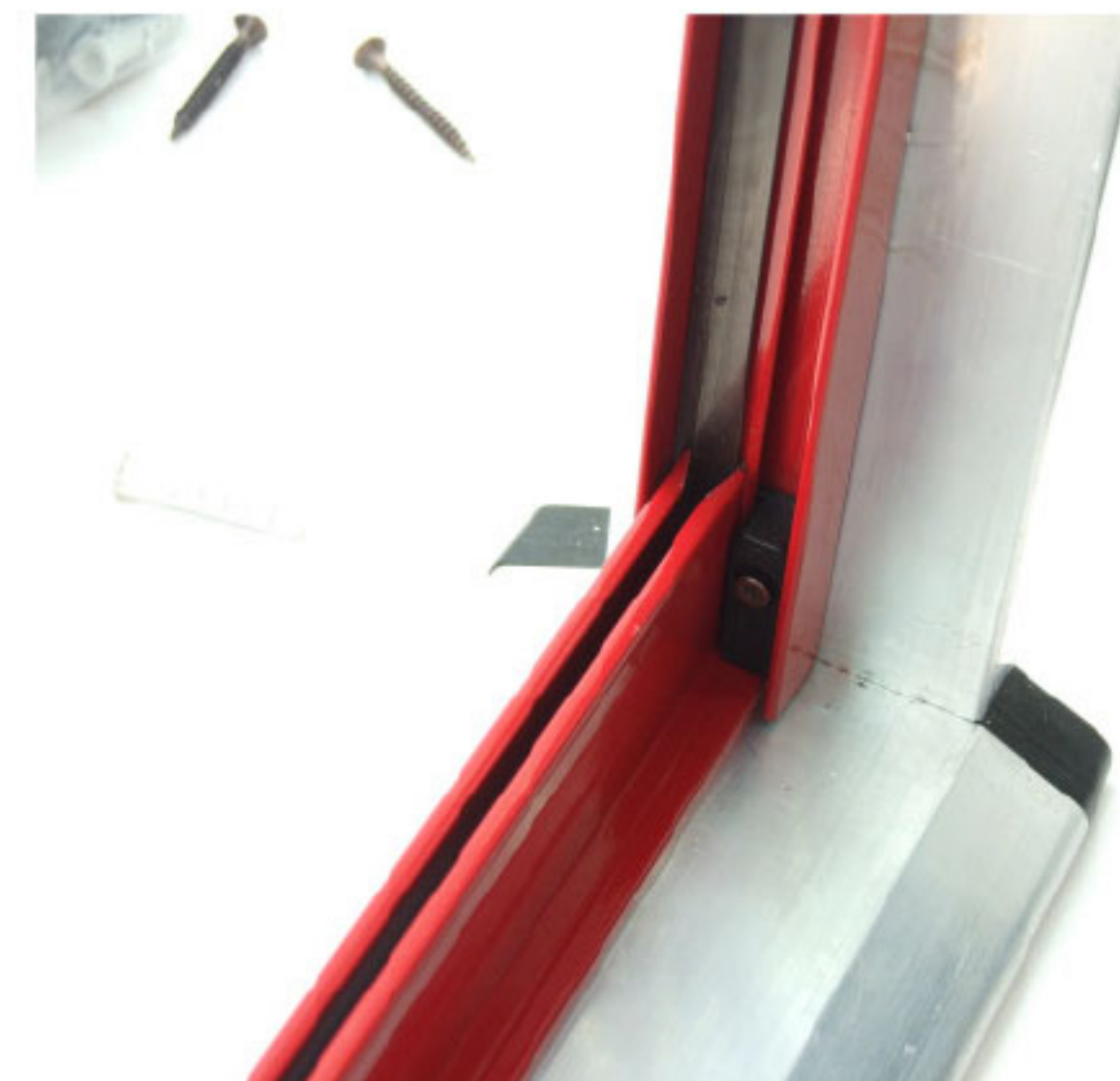
14 fissa la guida con tacchettino senza forare
