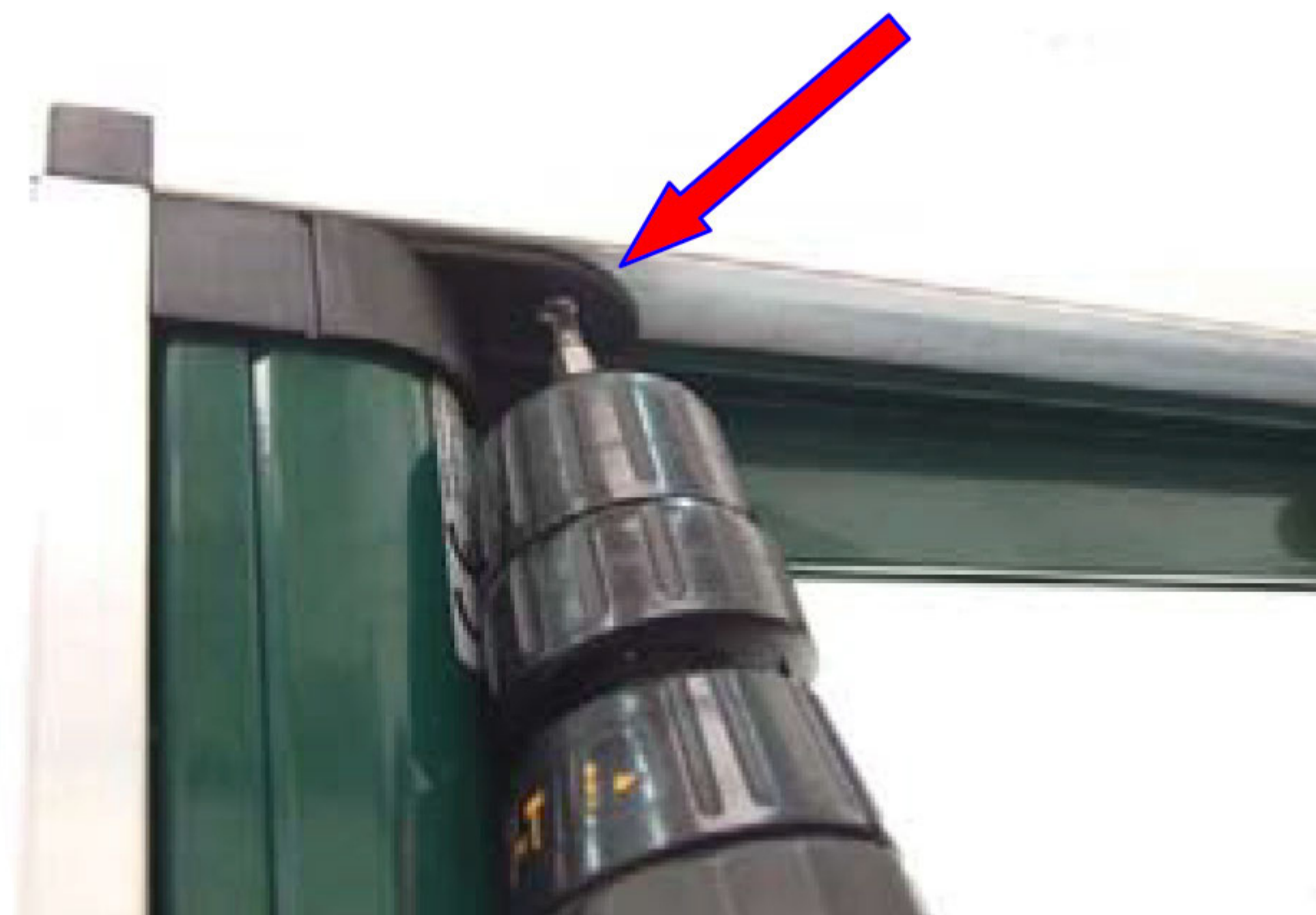
6° avvitare l'attacco guida
