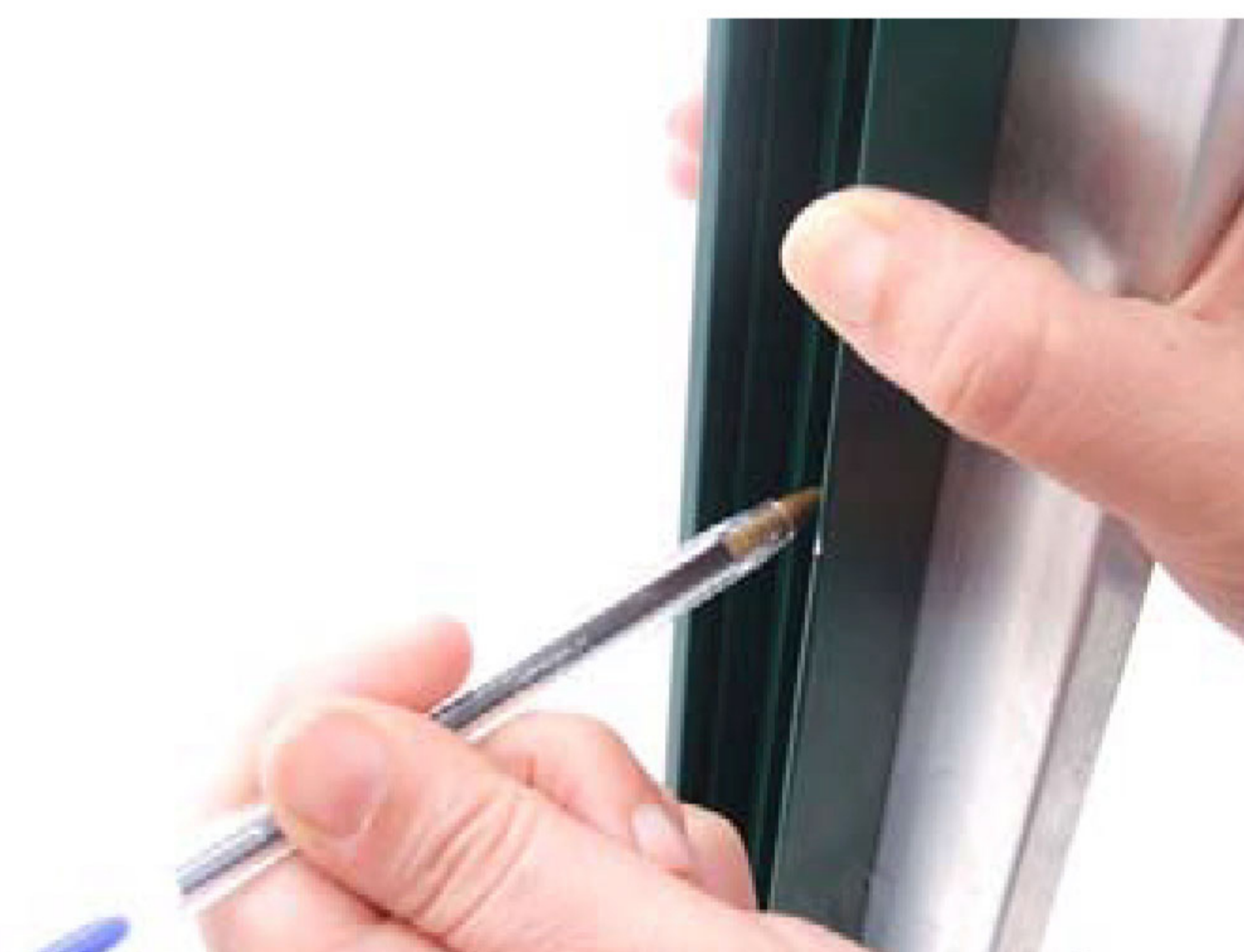
11° segnare i tre punti già forati sulla guida
