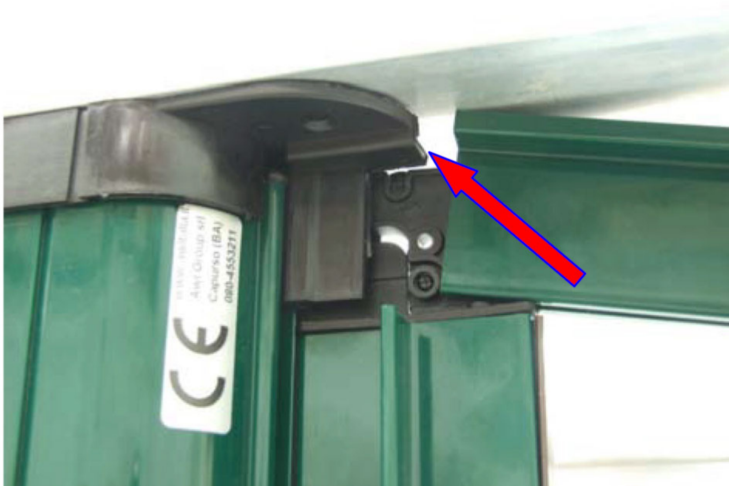
17° inserimento della guida superiore
