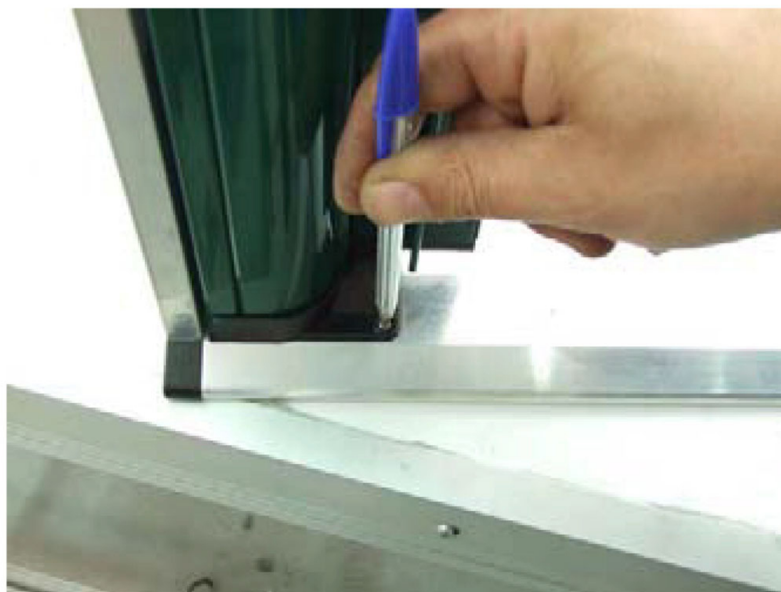
3° segnare la testata inferiore
