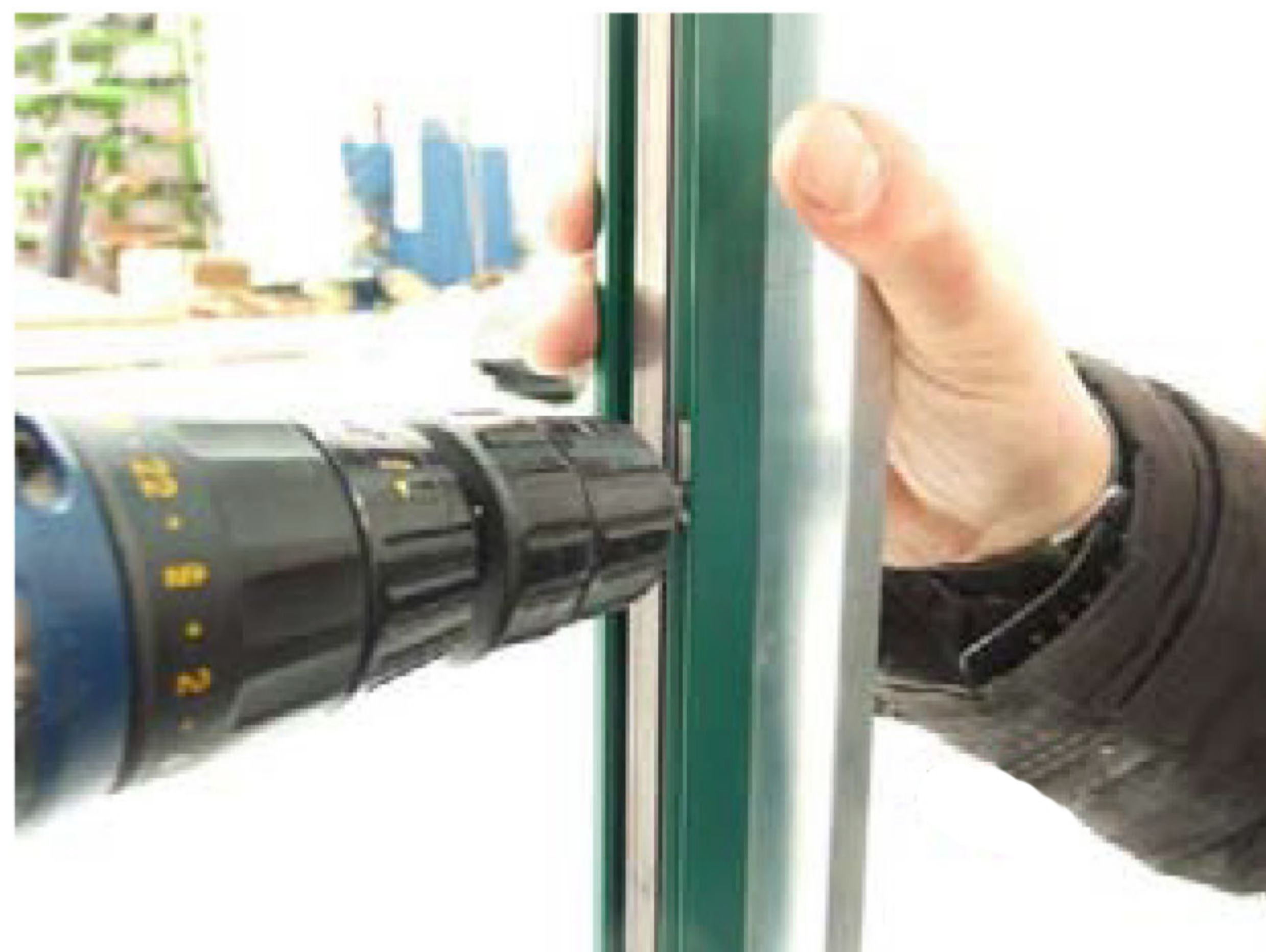
20° fissare guida a muro, nei tre punti
